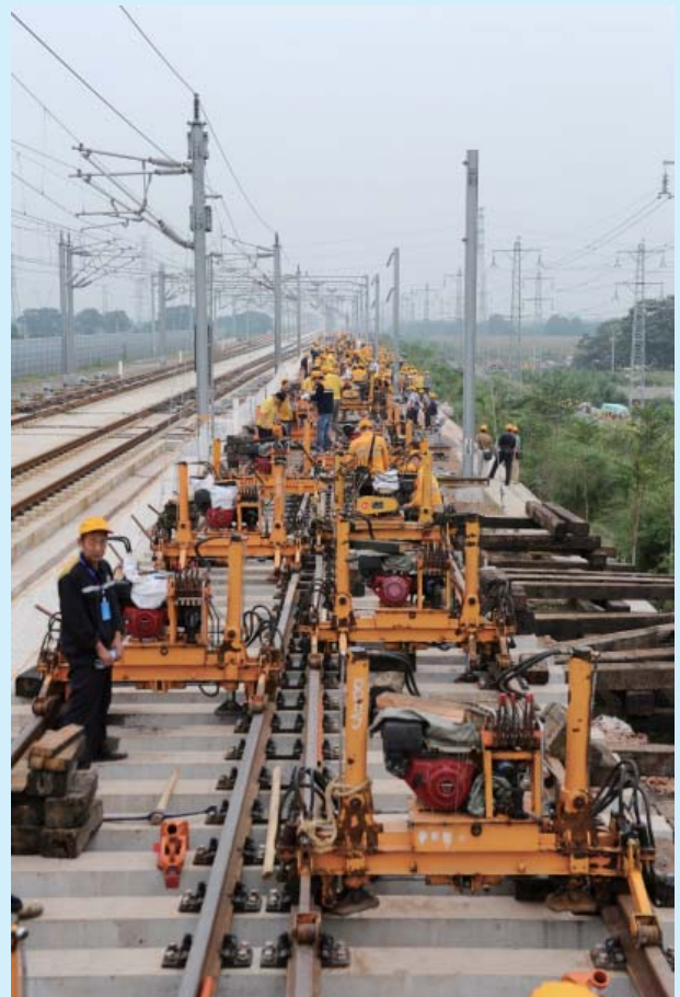
全国首例高速铁路道岔施工
