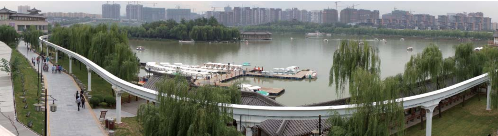
西安曲江新区观光轻轨工程
