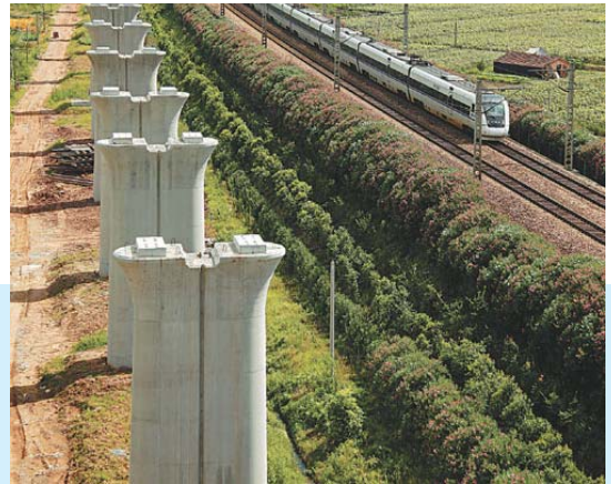
高墩施工注重生态保护
