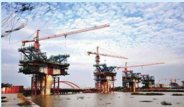
沪昆铁路客运专线浙江段施工
