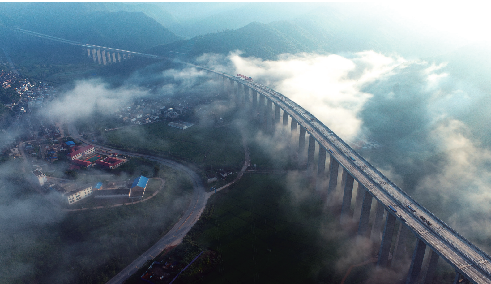
雲南玉楚高速公路阿姑特大橋
