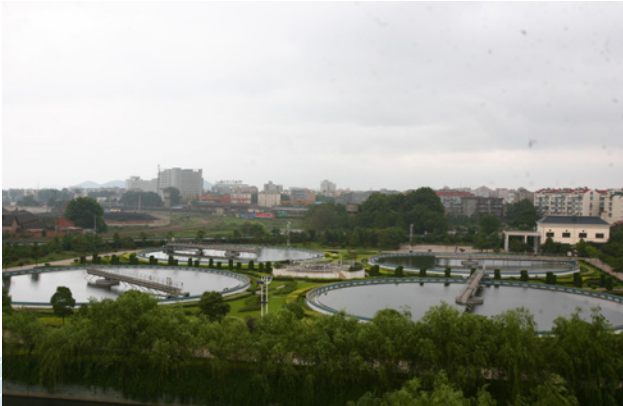
马鞍山中铁水务公司二沉池
