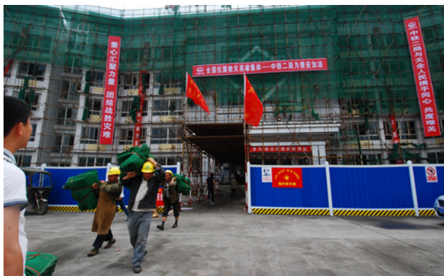
雅安地震发生后中铁二局紧急加固抢修天全县学校、医院房屋
