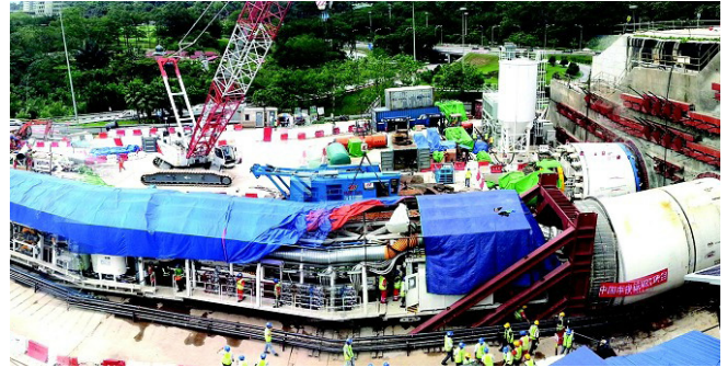
中国在马来西亚的首台盾构“中国中铁50号”在吉隆坡地铁项目始发
