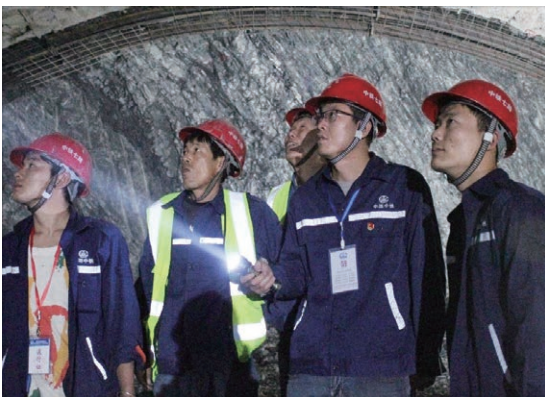
● 中铁七局三公司玉楚高速项目部姜春平安全护卫队在隧道掌子面检查安全
